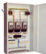
Шкаф с разъемами для подключения кабелей (устанавливается снаружи кожуха или контейнера)
